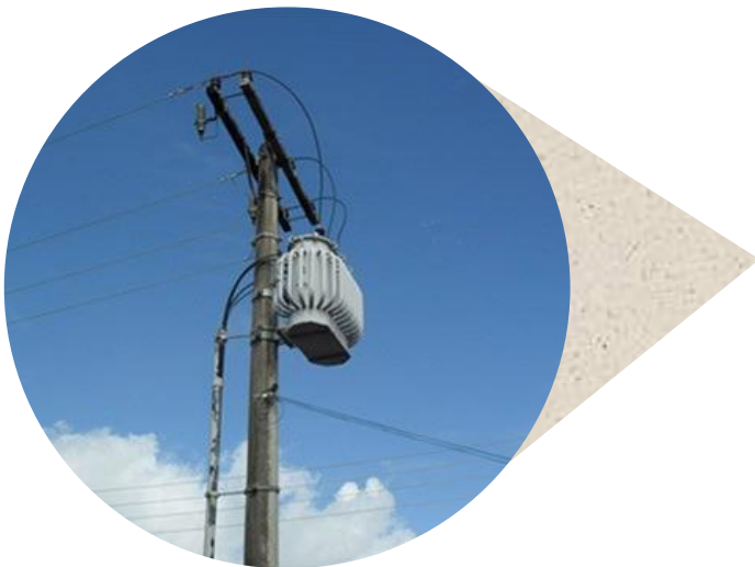
Poste de energia elétrica com transformador
