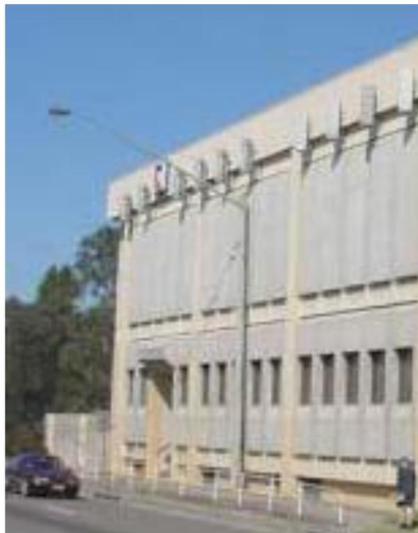
**Figura 28: Ordenação das antenas seguindo o padrão da fachada<sup>12</sup>**
