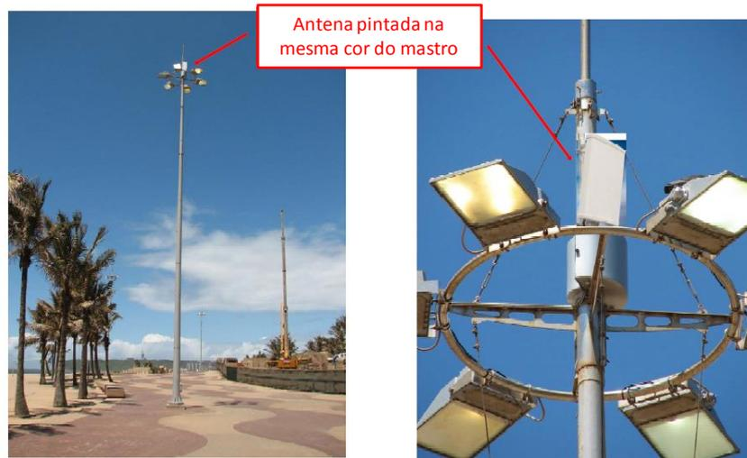
**Figura 22: Utilização de pintura para camuflagem de antena em poste de iluminação<sup>8</sup>**
