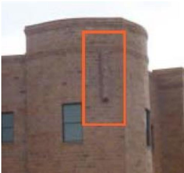
**Figura 20: Antenas camufladas em uma fachada de tijolos a vista<sup>6</sup>**
