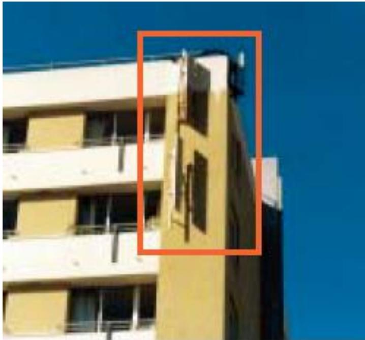
**Figura 19: Antenas camufladas utilizando mais de uma cor de pintura<sup>6</sup>**
