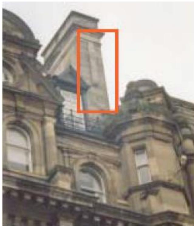
**Figura 21: Antenas camufladas em uma fachada de pedra<sup>7</sup>**
